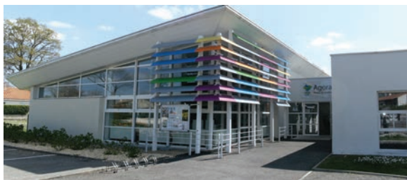
MAISON DE QUARTIER AGORA 6, rue des Violettes
