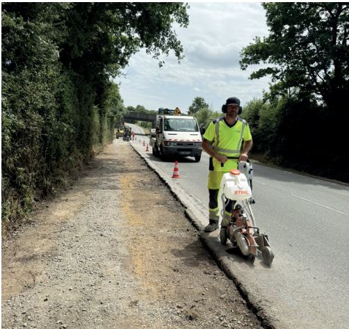
Travaux de réfection
