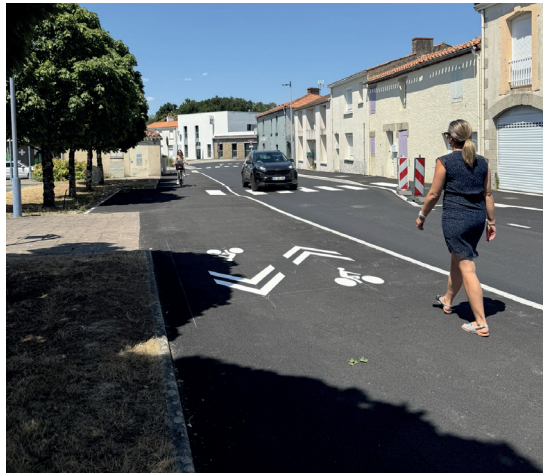
Aménagement de sécurité
