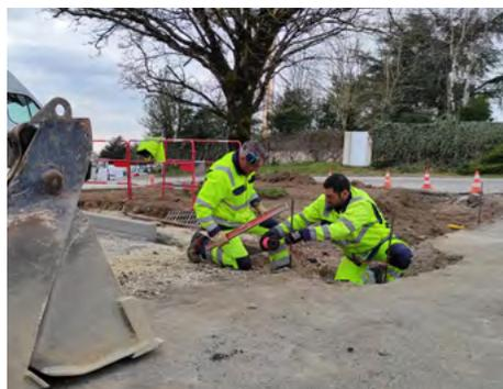
Les travaux d'aménagement d'un parking rue de la Montparière vont permettre la création de 34 places de stationnement. Ils sont entièrement réalisés par les agents du service Voirie. Une partie de cet aménagement est effectuée avec des pavés drainants pour une meilleure infiltration des eaux pluviales. Les arbres ont été préservés et d'autres vont être plantés. Un cheminement depuis la rue du Lac est également prévu.
